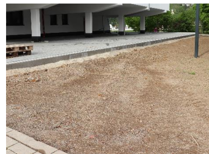
Bodenverdichtungen während der Bauphase
