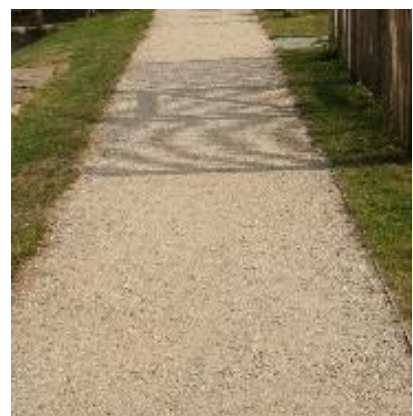
Wassergebundene Decke
